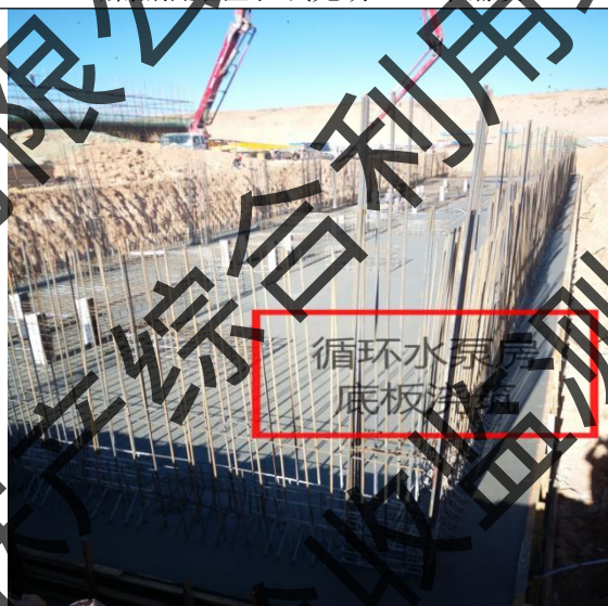
六化建循环水泵房底板浇筑
