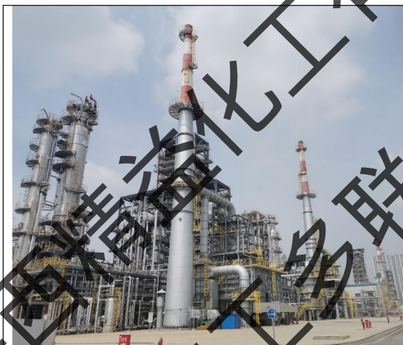
固定床 60m 排气筒
