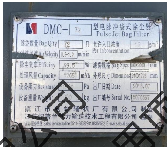
2#灰库除尘器铭牌
