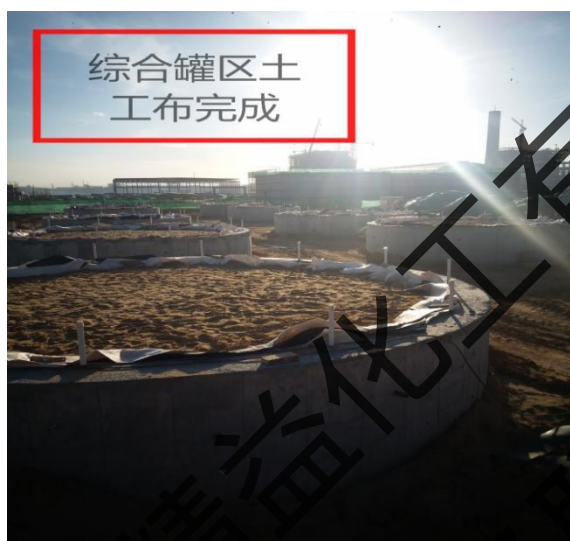
六化建综合罐区土工布铺设
