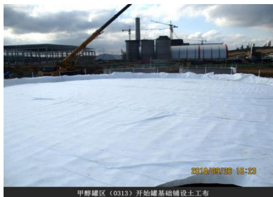
甲醇罐区(0313)开始罐基础铺设土工布
